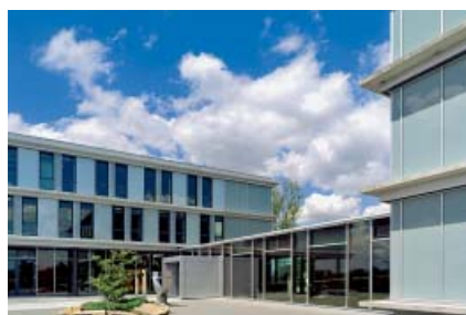
Dienstleistungszentrum Solpark Sparkasse Schwäbisch Hall – Crailsheim Drei Architekten Haag Haffner Stroheker, Stuttgart
