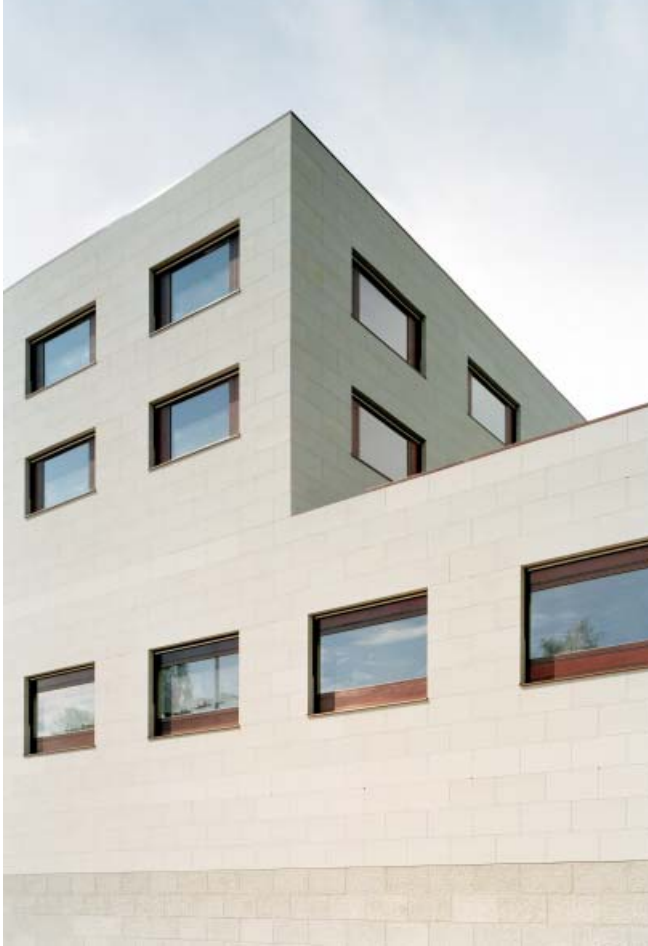
6 Gleichmäßig gesetzte, liegende Fensterformate mit bronzefarbenem Metall gerahmt, unterstützen den Eindruck des sachlichen Baukörpers mit seiner Ruhe und Stärke
